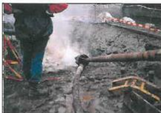
Foto 3.5.2-3 Perforación piloto
