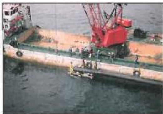
Foto 3.5.2-6 Preparación de tubería antes de fondeo
