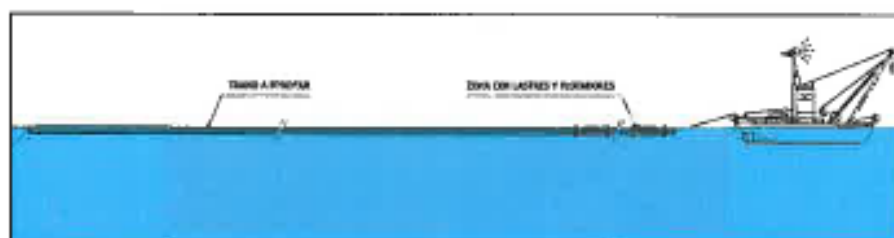
Figura 3.5.2-3 - Tubería flotando preparada para ser introducida en el túnel, con tramo difusor con lastres y flotadores
