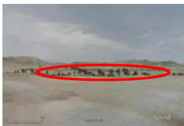
Vista del frente de obra de la PTAR desde Villa Mercedes (zona de recreación de niños)
